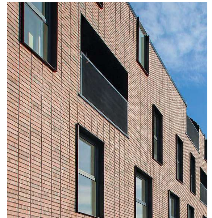
Budynek mieszkalny Nowy Werdon, projekt: www.maleccy.com
