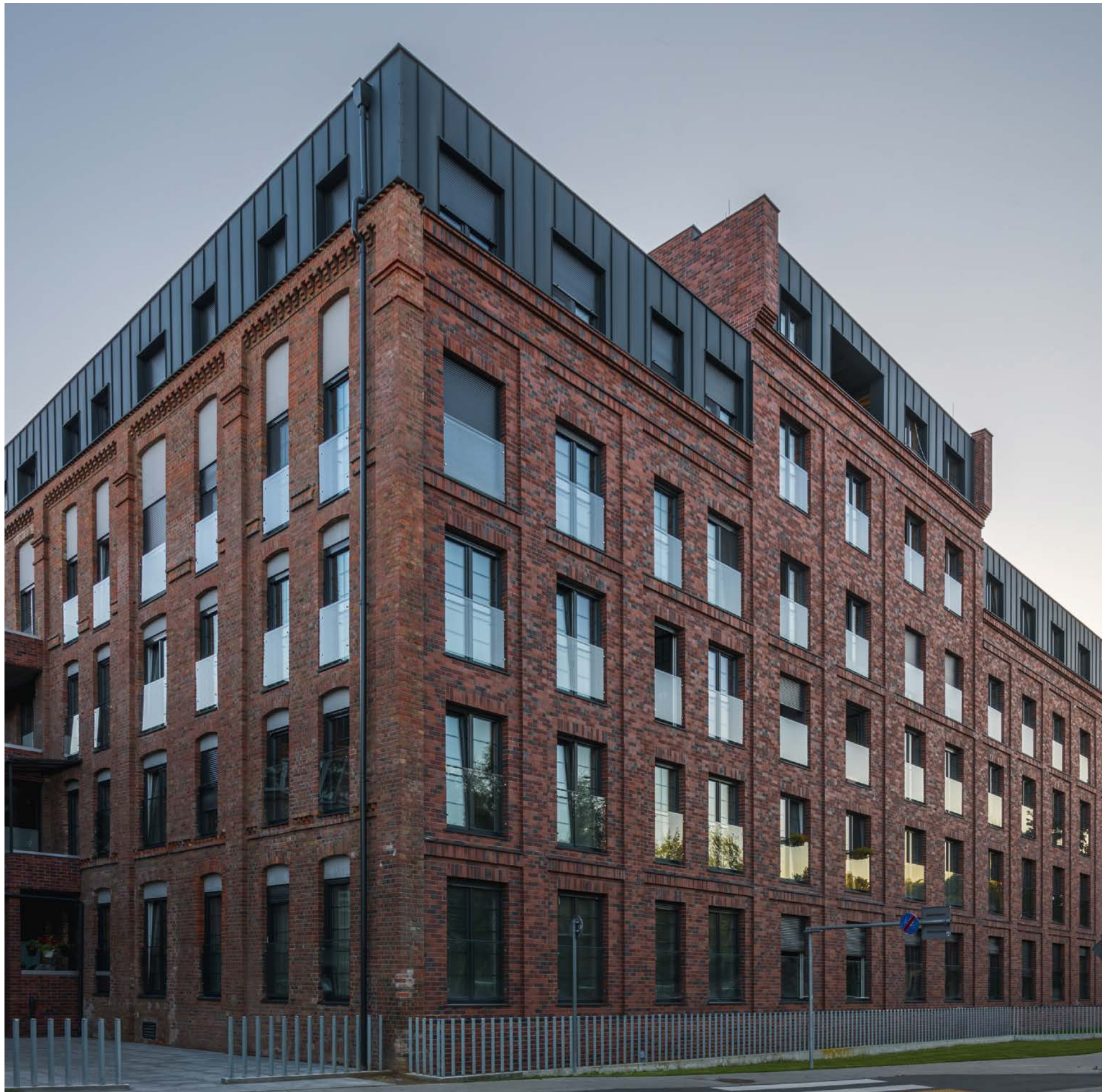
Bloki mieszkalne Młyn nad Cybiną, projekt: www.mconstructions.pl Inwestorzy: Grupa PARTNER, Przedsiębiorstwo R.Derda
