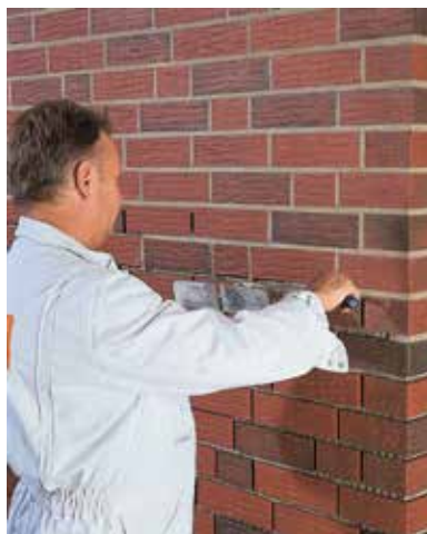
spárování obkladu spárovací maltou quick-mix FM
