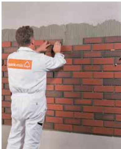
lepení cihlového pásku v ploše
